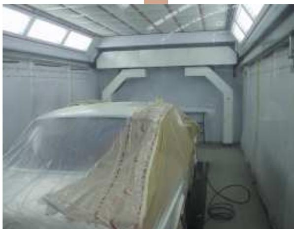
**Trattiene a terra le particelle** di polvere impedendone il deposito sui pezzi in verniciatura.
